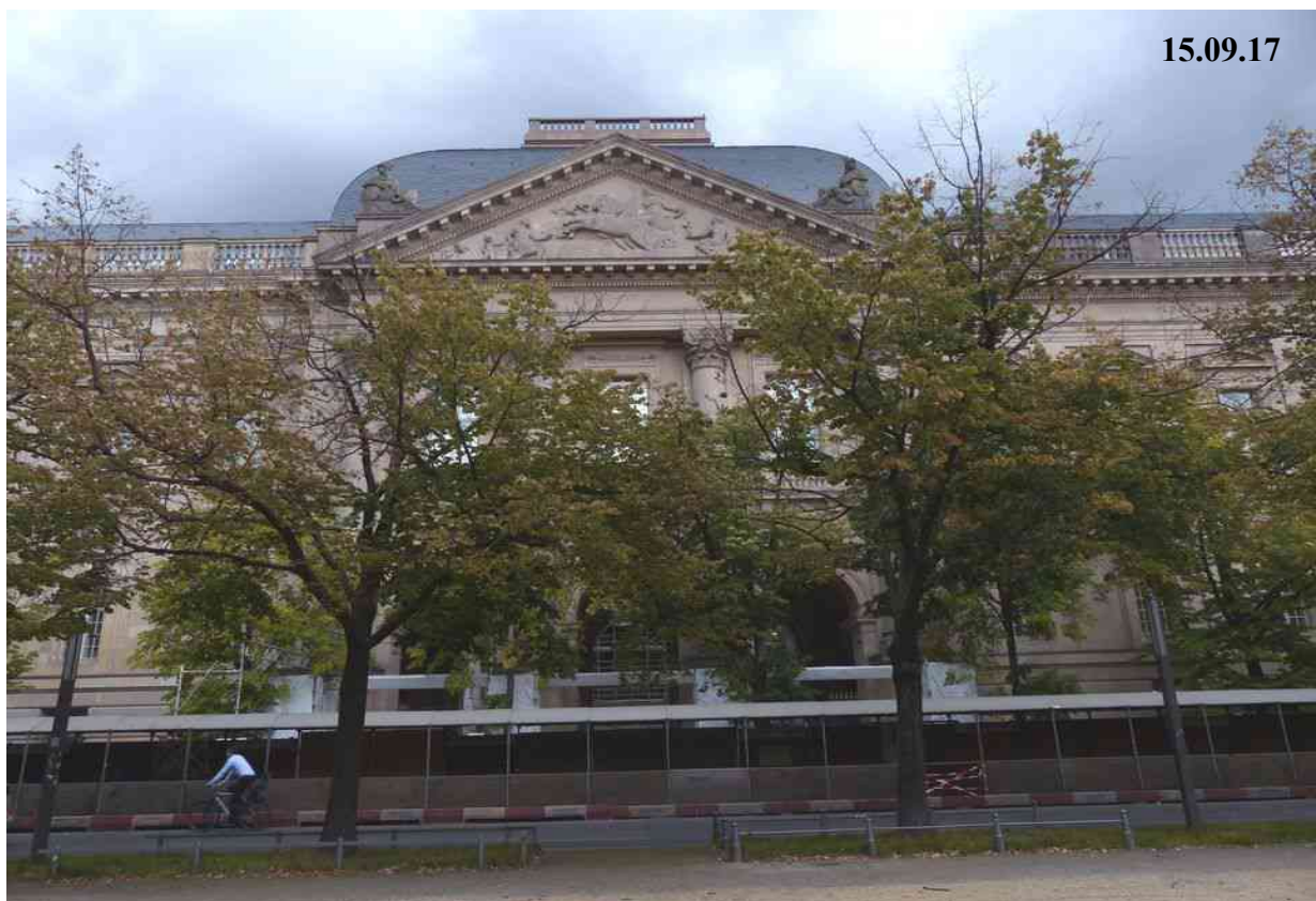
Blick von Süden über schwer geschädigte Linden auf die Staatsbibliothek.
